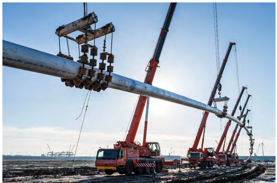
Het Warmtenetwerk kruist het Infrabel rangeerstation Antwerpen Noord ondergronds. Om dat te realiseren werd via een horizontaal gestuurde boring 1 kilometer aan Staal-in-Staal leiding ondergronds getrokken.
