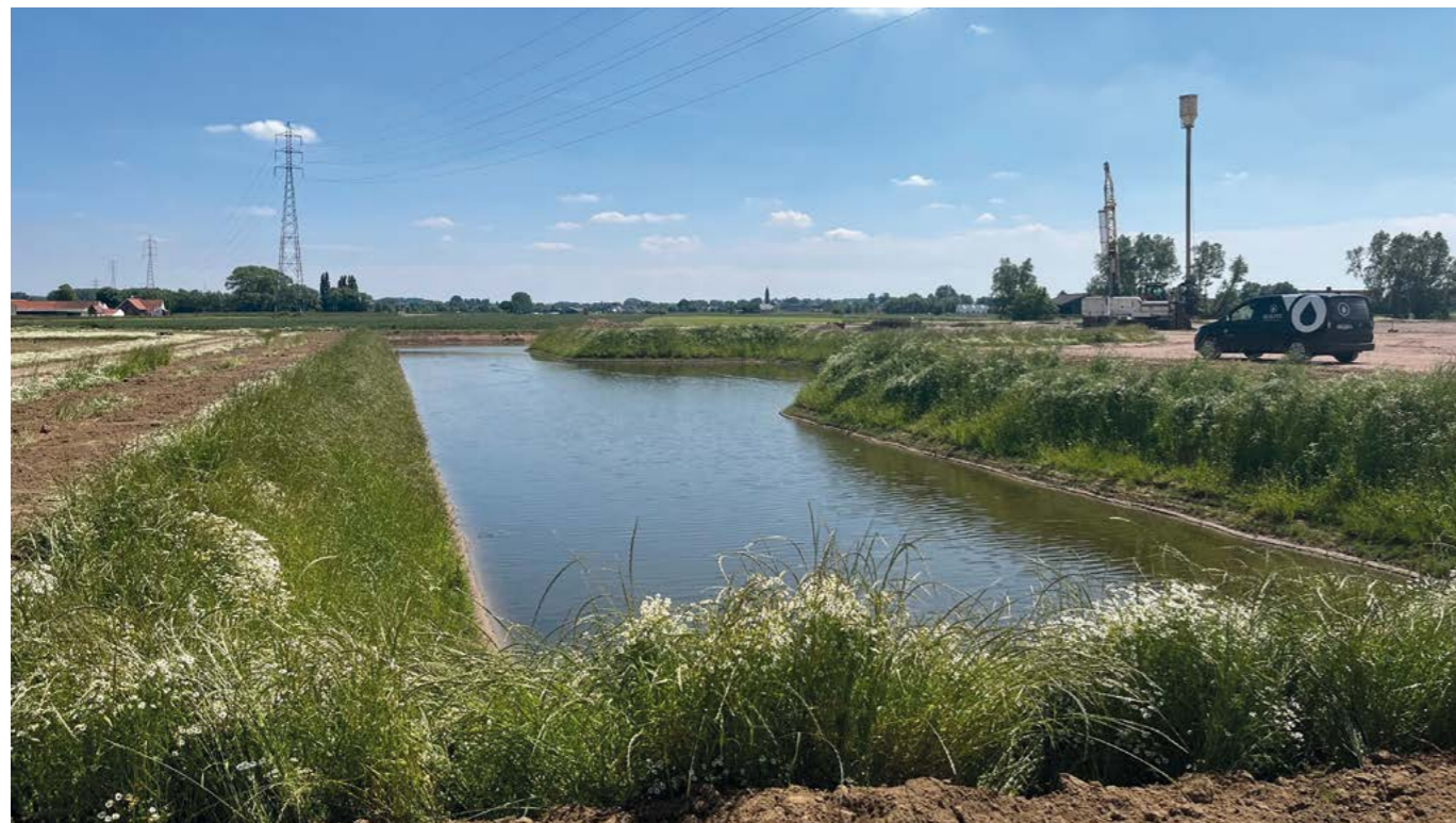
Voor dit project plaatste Sealtec een bufferbekken in een 1.5 mm HDPE folie.
